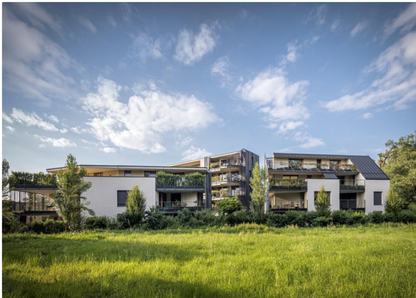
Blick von Süd-osten auf die beiden kleineren, vorgelagerten Baukörper; Foto © Jessica Alice Hath
