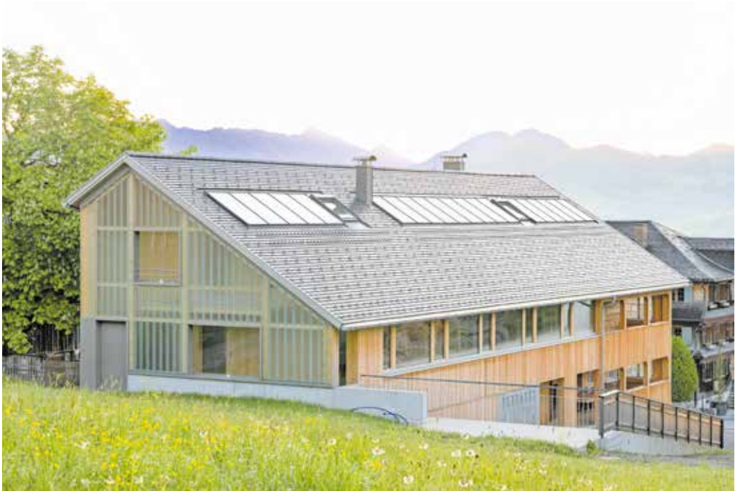
Neue Fenster öffnen den Blick auf den Ort und verbinden die historische Struktur mit heutigen Wohnanforderungen.
