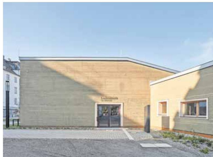
GESTAMPFTE ERDE. Das Gebäude ist der erste freitragende und bewitterte Lehm- und Tonbau in Deutschland. In seiner Fassade wechseln sich große und kleinere Fensterformate unregelmäßig ab.
