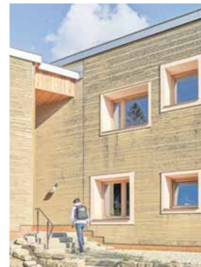
DIE WÄNDE sind aus großen Lehmblöcken gefertigt, die von Lehm Ton Erde Baukunst in Schlins vorgefertigt wurden.
