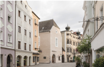
Markthalle © Tp3 Architekten
